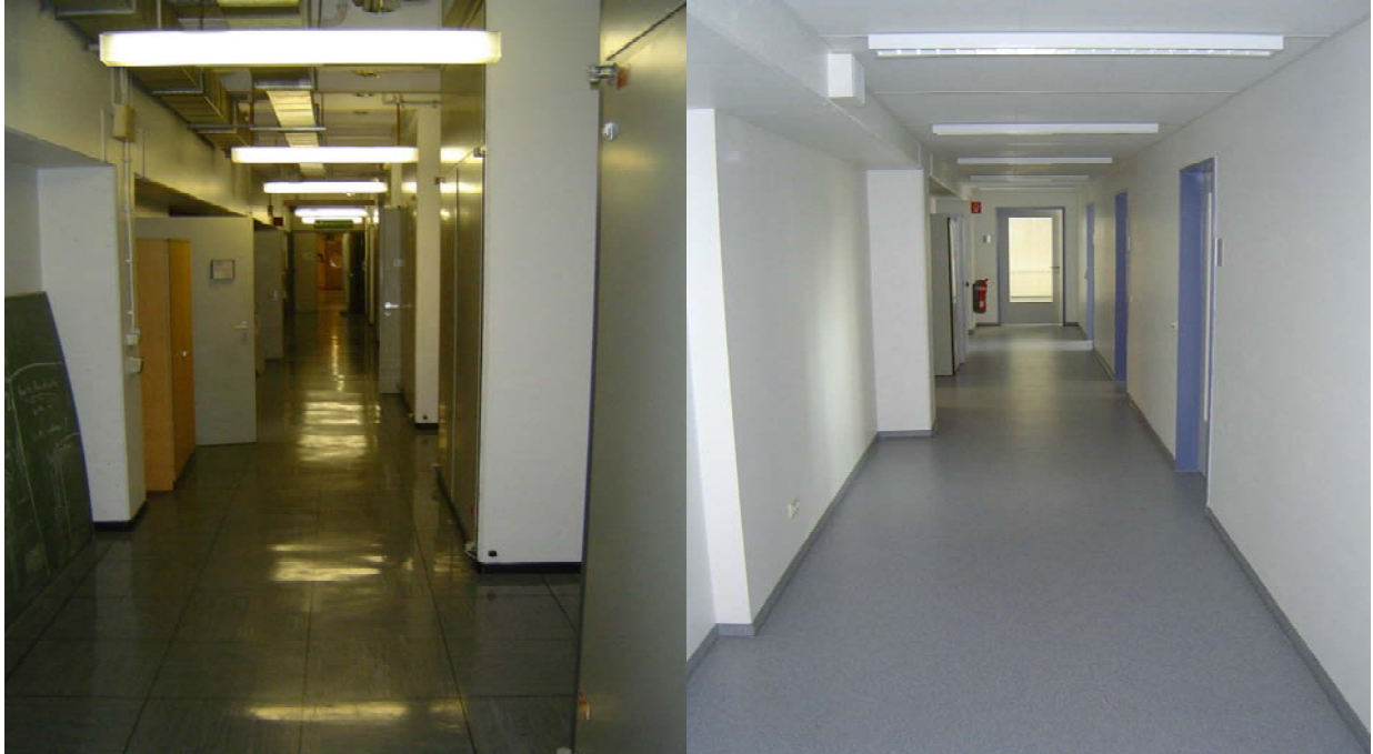
Bild 2-15: Flurbeleuchtung: vor der Sanierung (Kunstlicht) und nach der Sanierung (Tageslicht)
