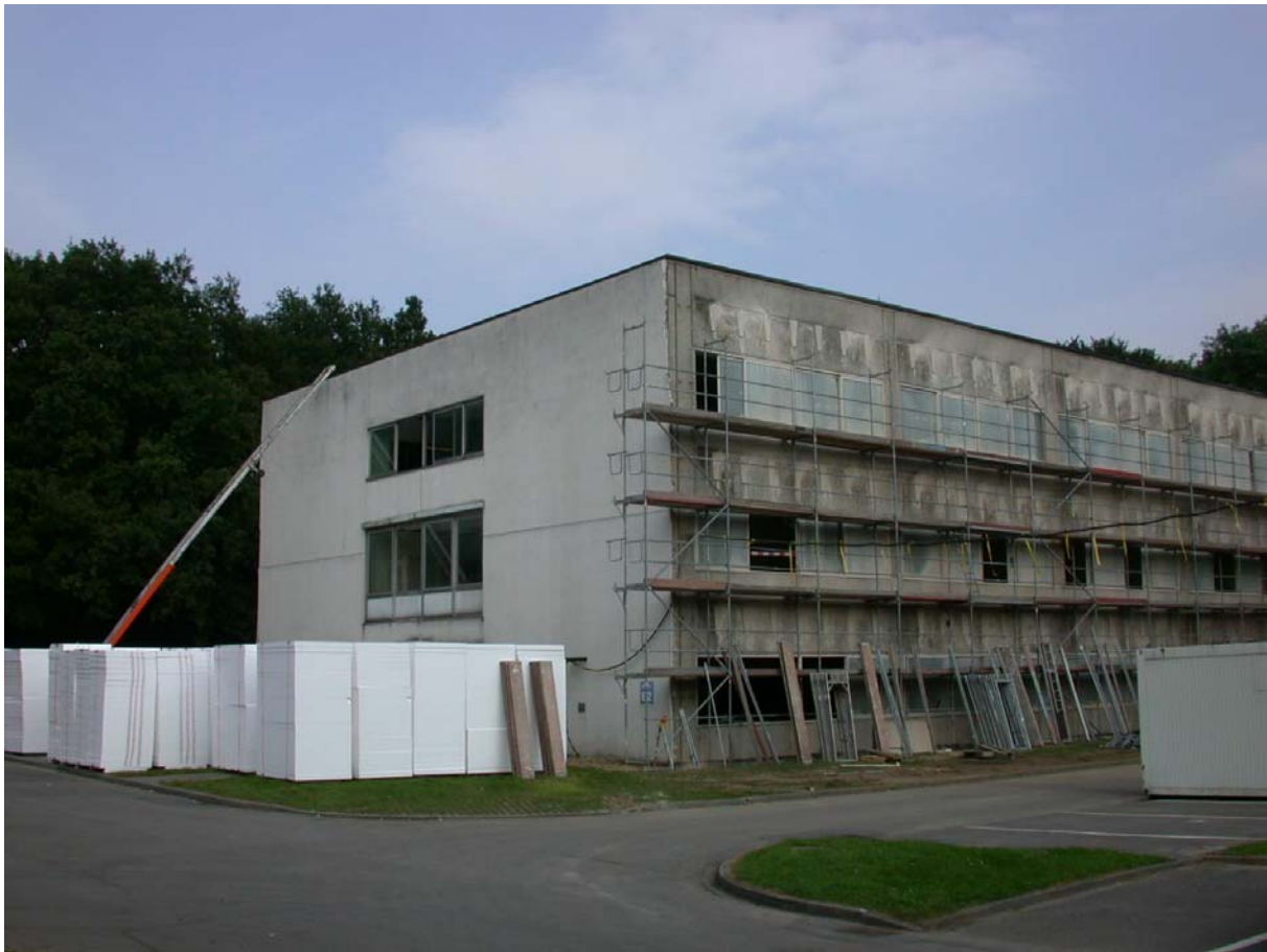
Bild 2-10: Gebäudehülle vor Beginn der Fassadendämmung
