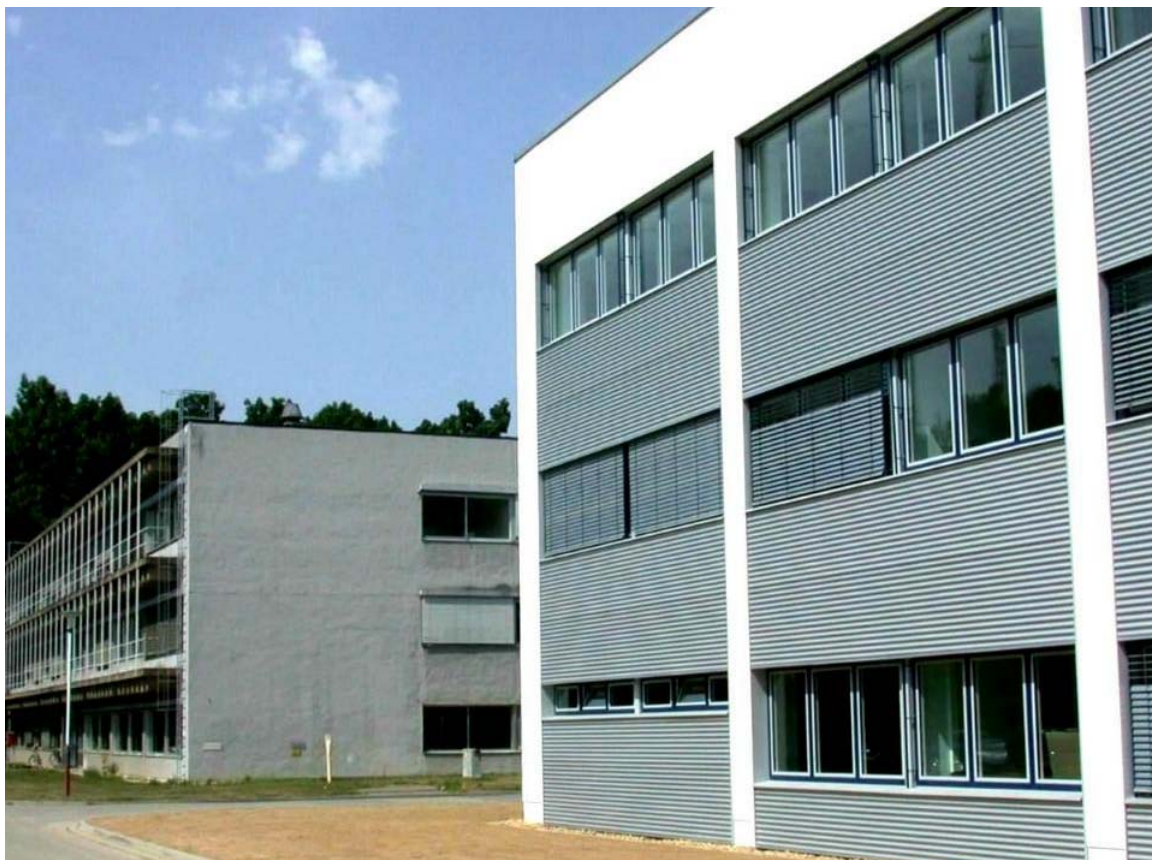
Bild 2-1: Gebäude 06.20 (Vordergrund) nach der Sanierung und das unsanierte Gebäude 06.10
