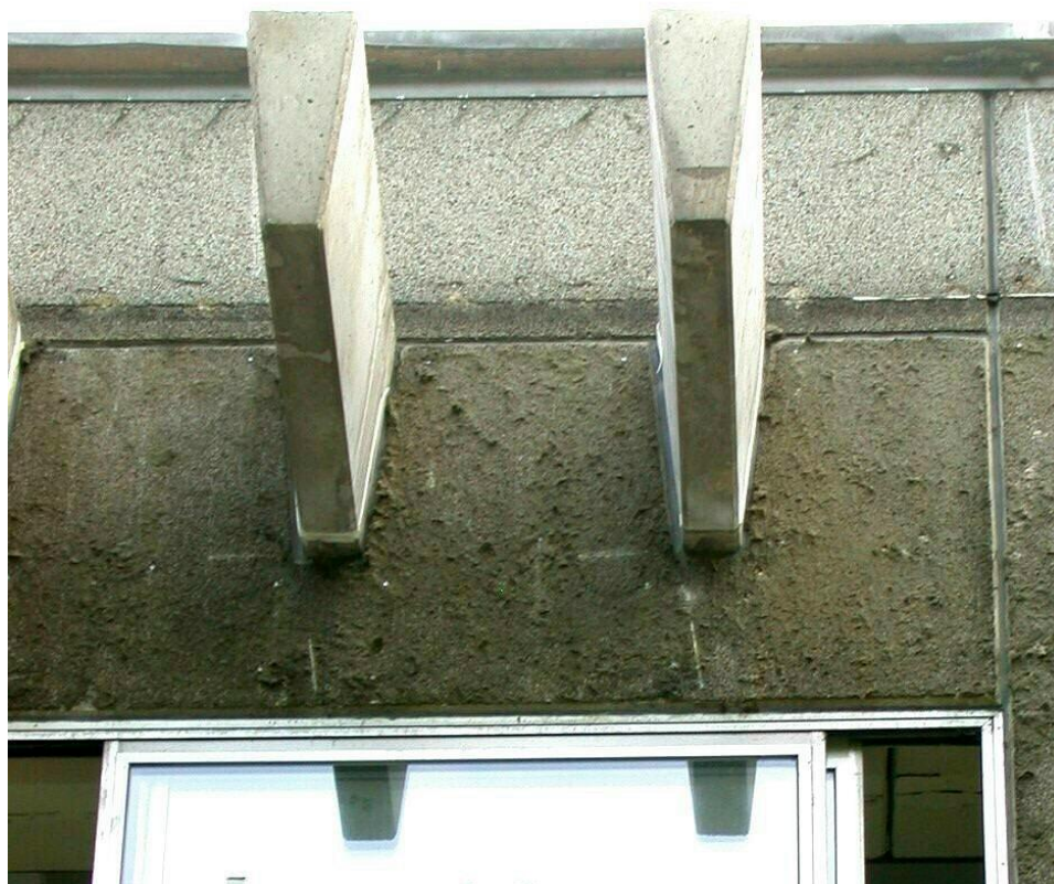
Bild 2-9: Kragarme unmittelbar vor dem Abschneiden
